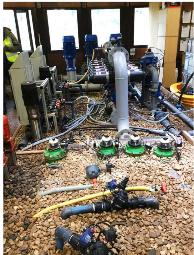
Kuva 25. Haygroven tilan pumppuhuone, josta lähtee venttiilit kaikille tilan lohkoille
