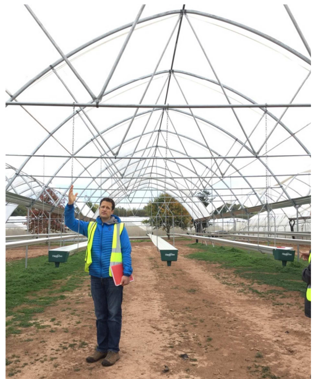
Kuva 24. Tunnelin tuuletus voidaan jatkossa automatisoida. Lisäksi on kehitetty roikkuva pöytämalli, joka mm. mahdollistaa robottipoiminnan tulevaisuudessa.
