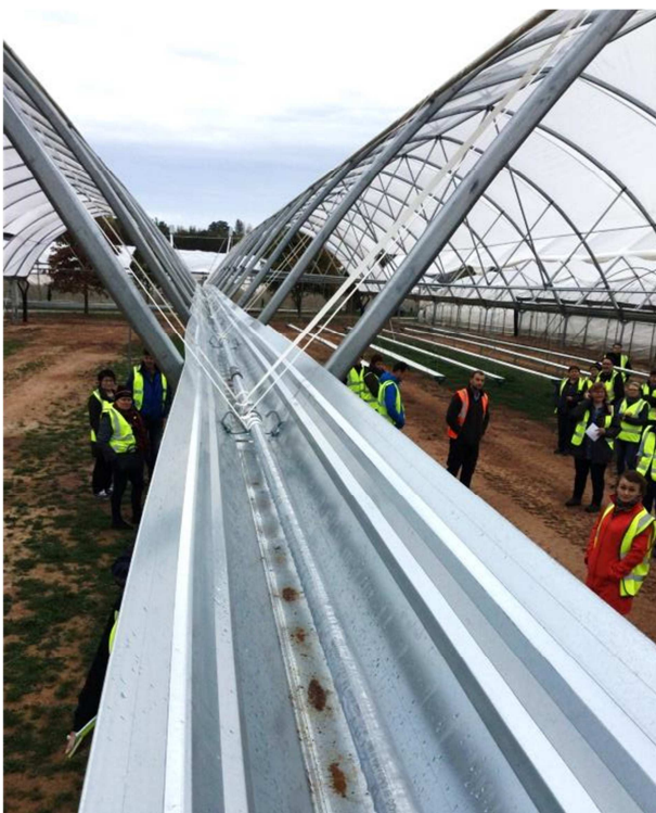
Kuva 24. Tunnelin tuuletus voidaan jatkossa automatisoida. Lisäksi on kehitetty roikkuva pöytämalli, joka mm. mahdollistaa robottipoiminnan tulevaisuudessa.
