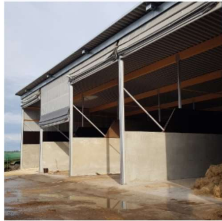
Apekomponenteille umpinainen varasto ja suojaus pressuovilla
