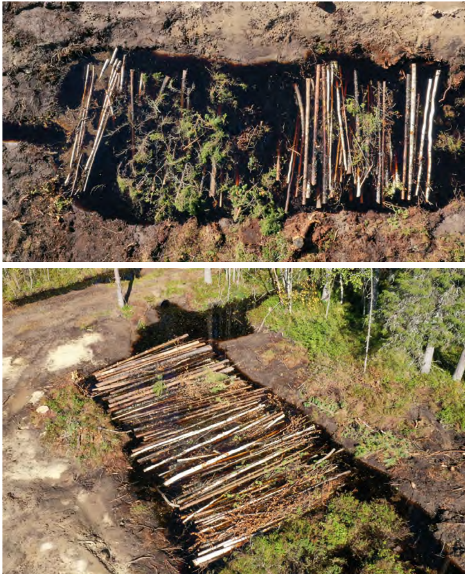
Kuva 20. Rankapuista ja latvuksista voi tehdä puukasetin vesiensuojelurakenteeksi.
