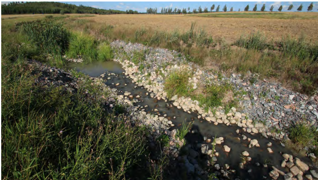
Kuva 22. Valmiiksi rakennettu kiverhoiltu pohjapato ja pohjapato 1 v kuluttua rakennustöistä.
