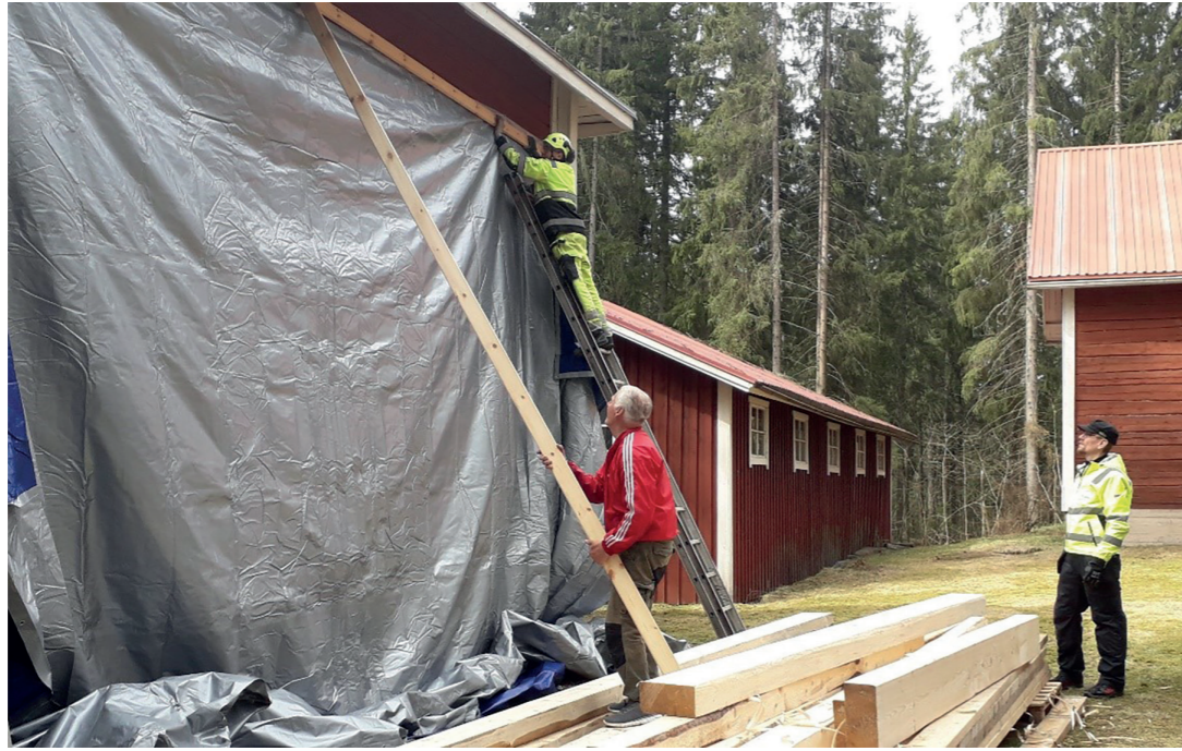
Rakennettua kulttuuriympäristöä suojellaan rakennuksia käyttäen ja hoitaen sekä lainsäädännöllä. Kuvassa hirsirakennuksen ”kengitykseen” valmistautuvia talkoolaisia Muuruveden kotiseutumuseolla. Kuva: Anna Koivukoski.
