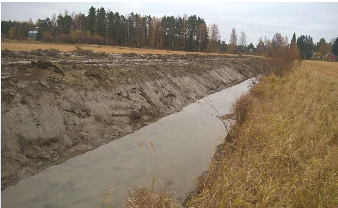
Toispuoleinen varovainen kaivu
